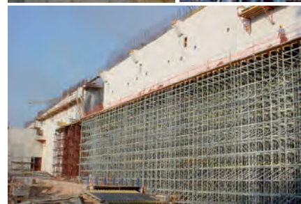
Vigas VPE (fase construtiva)
