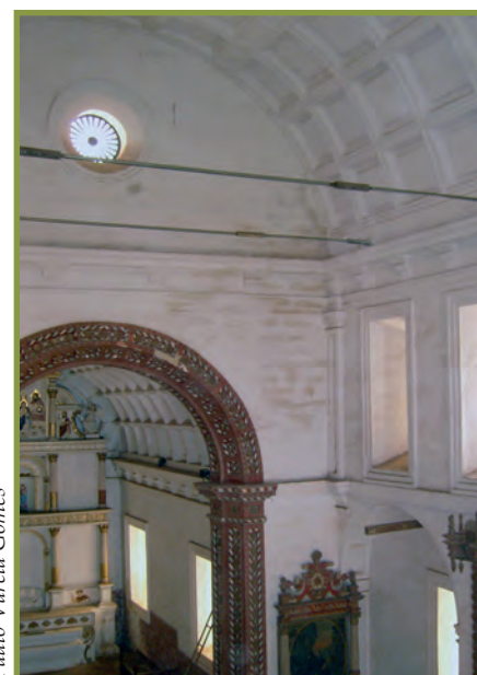
A Capela do Monte hoje: interior, vendo-se dois dos tirantes de aço
