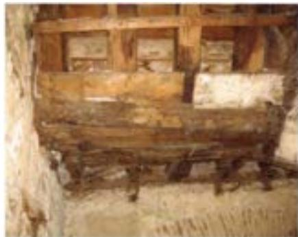
Fig. 2 – Deformação da estrutura de suporte da escada
