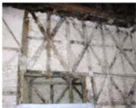
Fig. 4 – Parede em frontal antes da intervenção
