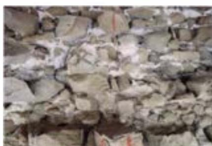
Fig. 3 - Estrutura das paredes - é visível o enchimento interior dos muros da couraça com pedra aglomerada com boa argamassa de areia e cal. No topo da imagem podem-se observar os sillares da primeira fiada que encamisavam a parede
