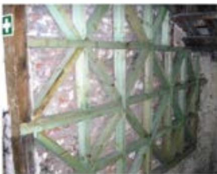
Fig. 5 – Parede em frontal reconstruída
