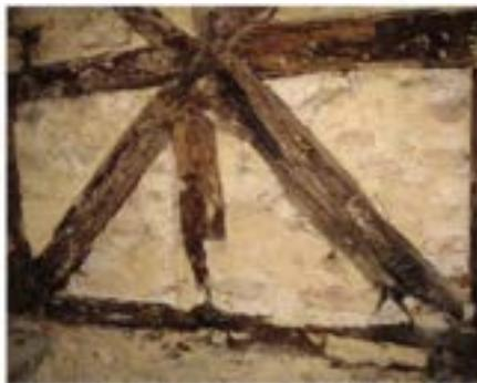
Fig. 3 – Pormenor de degradação de elementos de madeira de uma parede em frontal
