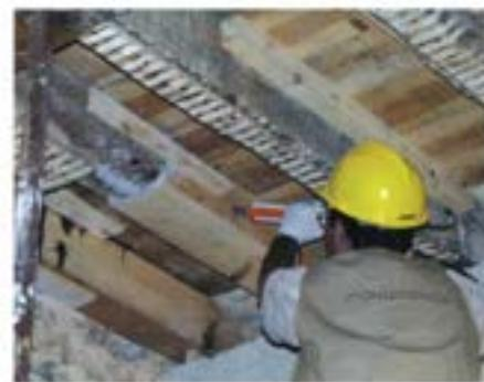
Fig. 6 – Aplicação de prótese – substituição selectiva de entregas adulteradas
