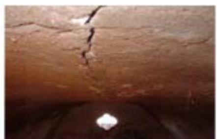
Fig. 3 - Fractura e deformação da abóbada da nave
