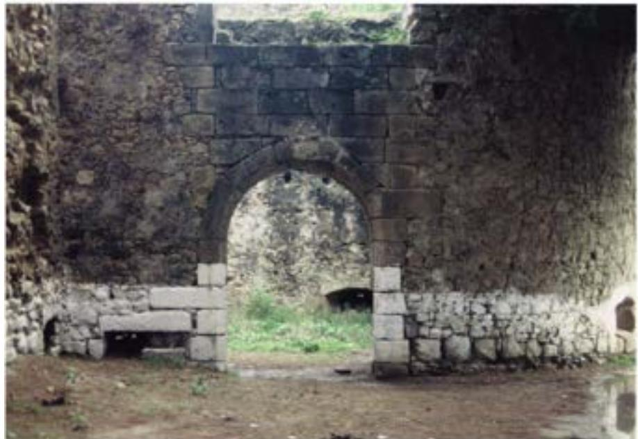
Fig. 2 - Porta da Terra - na prática era a Porta da Vila. Sendo também um ponto crítico da defesa era protegida por canhoneiras na base das muralhas que faziam tiro rasante ao terreno. Em arco pleno, o vão era ressalvado por um bem ordenado paramento de sillares de pedra
