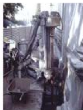
Fig. 4 - Execução de microestacas - lintel exterior à fachada lateral - fase de furação em profundidade
