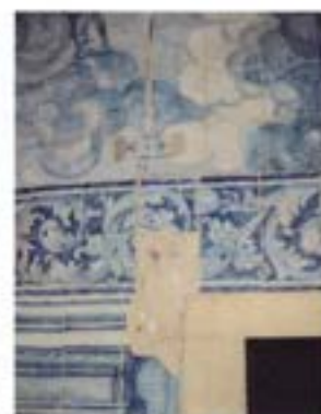
Fig. 3 - Controlo de abertura de fenda estrutural parede interior, revestida com painel azulejar
