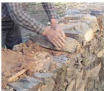
Requalificação do acesso ao poço em Cachopo: muro de alvenaria de xisto. (Gta Sotocento 2005)
