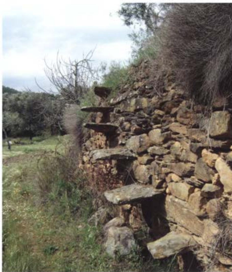
Muro limite de propriedade, contenção de terras e elemento de humanização da paisagem e escadas em laje de xisto, vencendo o desnível entre os socalcos
