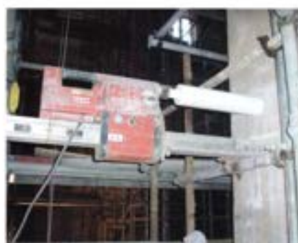
Fig. 9 - Reforço de pilastras por pregagens resistentes ocultas - fase de furação com carotadora
