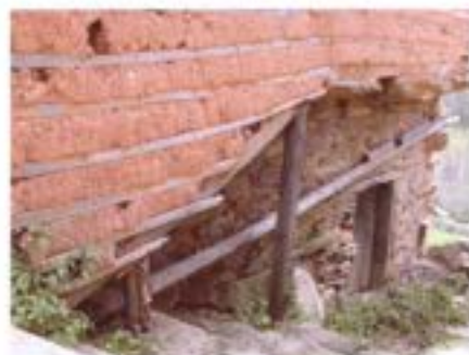
Diálogo de tradições construtivas: alvenaria mista e taipa, testemunhando o uso da pedra como elemento estrutural no piso inferior e a utilização de uma solução material menos pesada no piso superior
