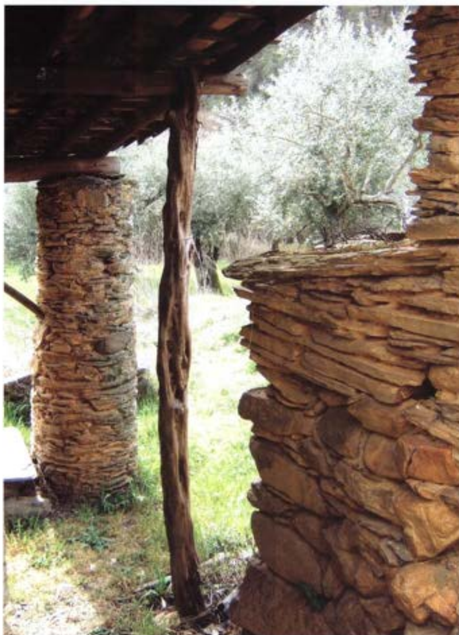
Elementos arquitectónicos singulares: pilar de secção circular em alvenaria de xisto com argamassa de base argilosa
