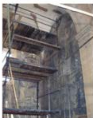
Fig. 8 - Protecção prévia de painel azulejar, para posterior consolidação e reforço de tectos e pilastras
