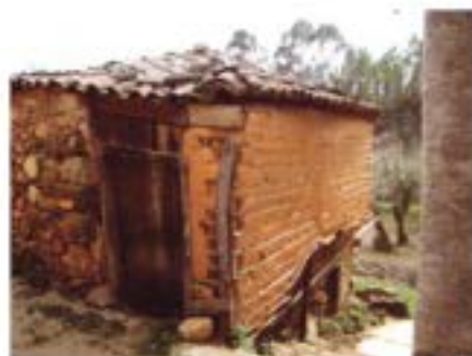
Diálogo de tradições construtivas: alvenaria mista e taipa, testemunhando o uso da pedra como elemento estrutural no piso inferior e a utilização de uma solução material menos pesada no piso superior
