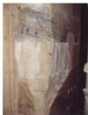
Fig. 2 - Controlo de abertura de fracturas gerais pela delaminação do revestimento das pilastras
