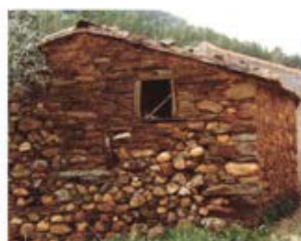
Recursos endógenos aplicados à construção: alvenaria mista de calhaus rolados e xisto
