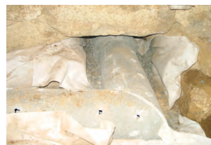
Fig. 13 – Tubagem perfurada do sistema de ventilação interior
