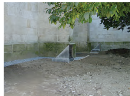
Fig. 9 - Contorno exterior da capela-mor após a conclusão do sistema de ventilação exterior
