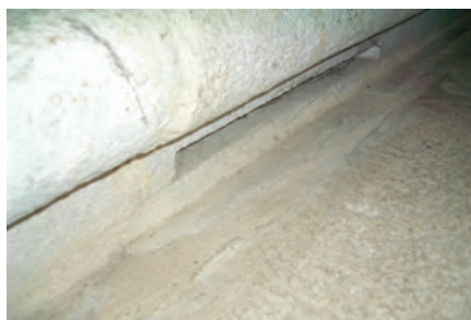
Fig. 16 – Rasgo no degrau de uma capela lateral para admissão ao subsistema interior Sul
