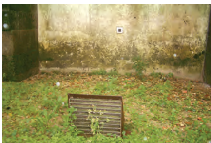
Fig. 14 – Abertura de extracção do subsistema interior Norte
