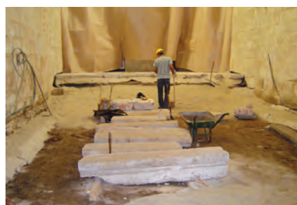
Fig. 12 – Trabalhos de realização do sistema de ventilação interior na capela-mor
