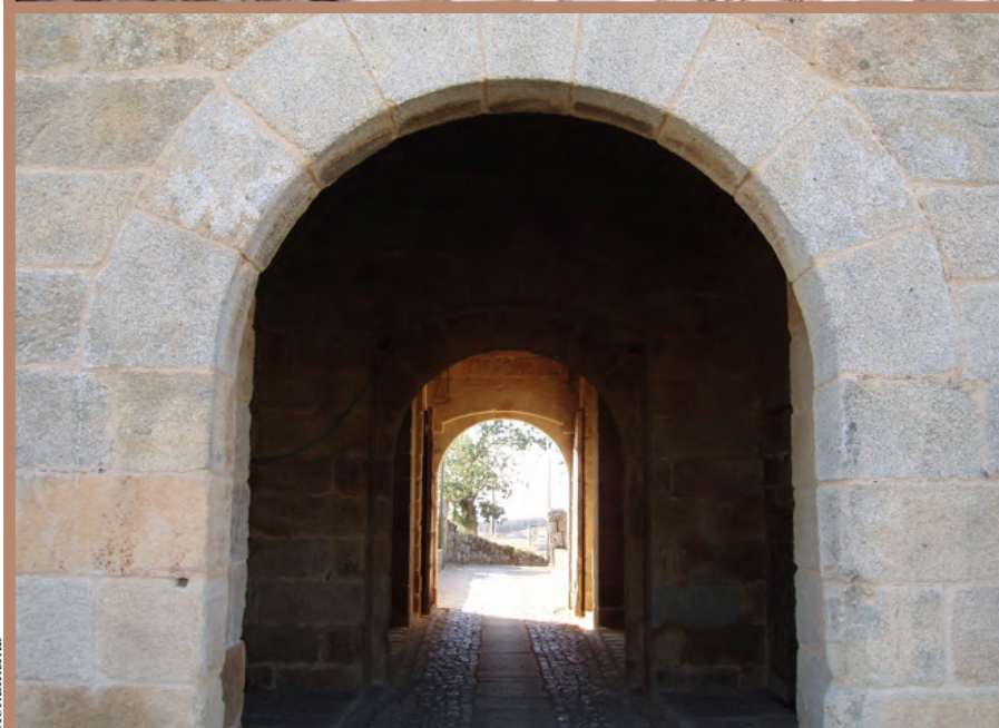
Fig. 6 - Resultado final de refecimento das juntas. Fábrica de Sedas Chamim, Macedo de Cavaleiros. Porta de Santo António, Almeida
