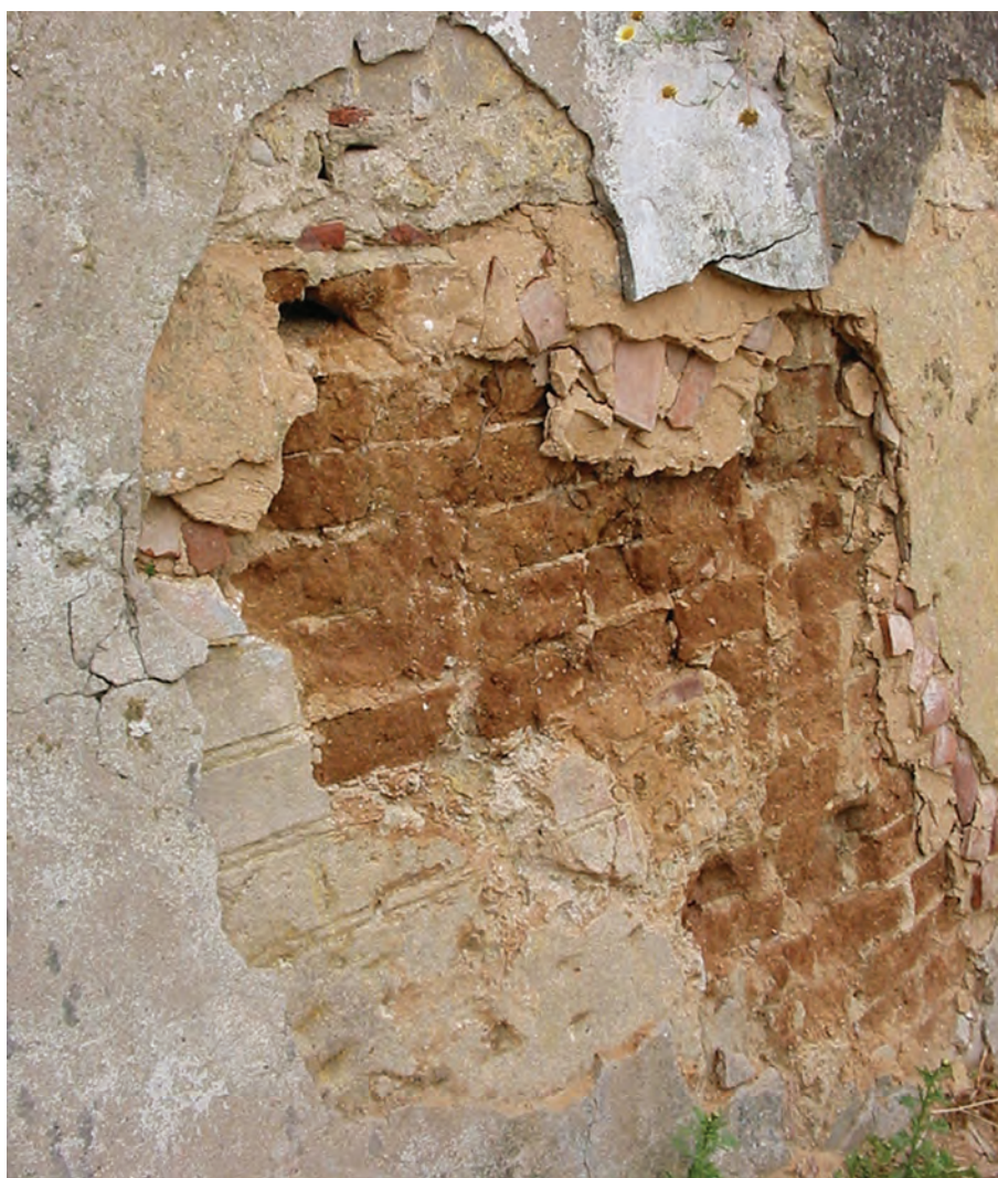
Degradação completa do sistema de revestimento exterior, expondo o suporte
