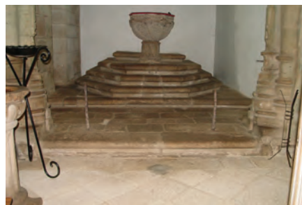
Fig. 6 - Manchas de humidade no pavimento da capela com Pia Baptismal
