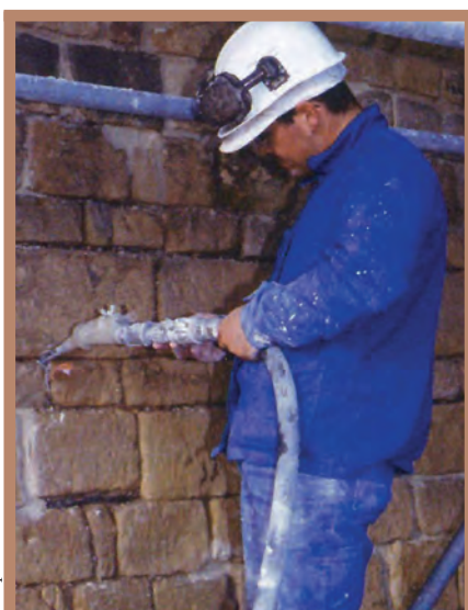
Fig. 5 - Colocação da argamassa de refecimento utilizando um equipamento
