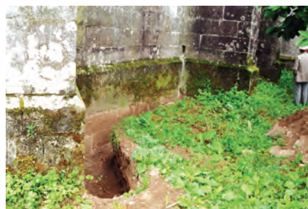
Fig. 3 - Sondagem realizada no exterior da capela-mor
