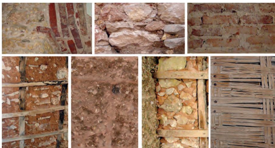
Fig. 4 - Tipos de aparelho construtivo identificados. Da esquerda para a direita e de cima para baixo: tijoleira disposta verticalmente; alvenaria de pedra; alvenaria de tijolo; tabique com enchimento de pedra e terra; taipa; taipa e tabique com enchimento de pedra e argamassa; tabique com ripado de canas
