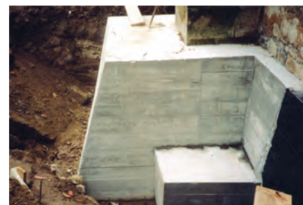
Fig. 4 - Reforço dos contrafortes do alçado Norte (Fonte: IPPAR)
