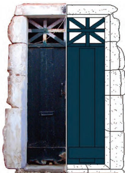
Fig. 3 - Análise de cantarias - levantamento gráfico e fotográfico
