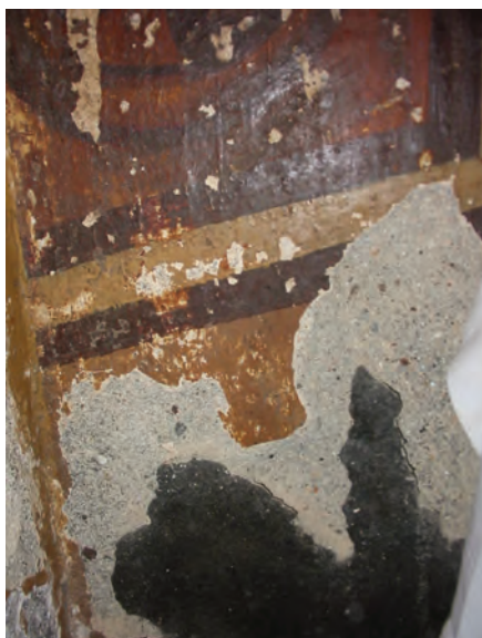
Degradação associada a problemas de ascensão capilar e aplicação de argamassa de substituição demasiado impermeável ao vapor de água em revestimento interior
