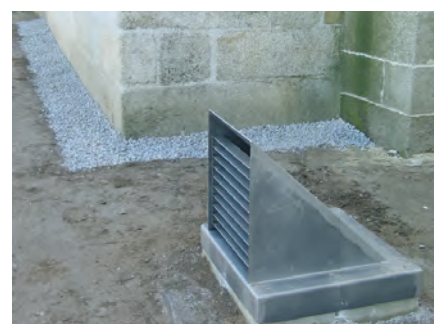
Fig. 10 - Abertura do sistema de ventilação exterior da base das paredes
