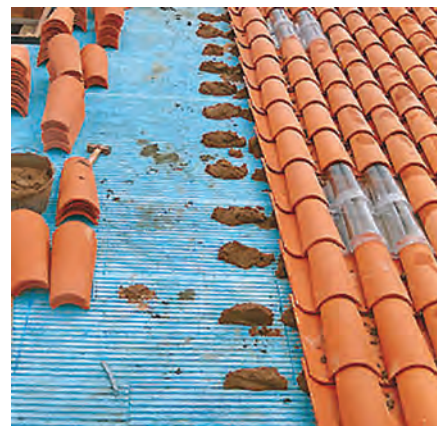
Fig. 7 - Reforço do isolamento térmico em coberturas inclinadas
