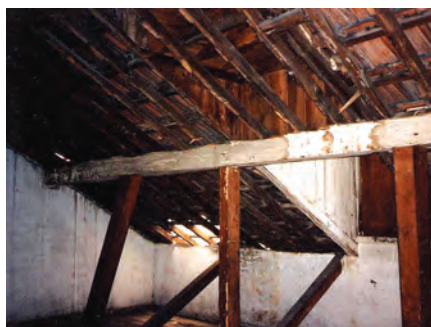
Fig. 2 - Degradação acentuada da estrutura em madeira da cobertura
