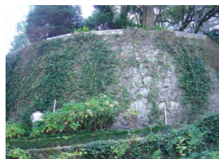
Fig. 2 - Muro em curva. Fenda com cerca de 5cm de abertura e ausência de revestimento
