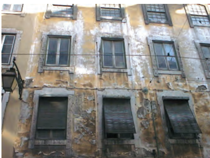
Fig. 1 - Degradação do revestimento da fachada
