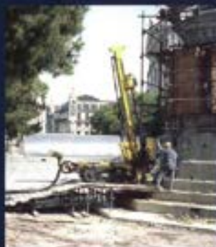
Consolidação das fundações de monumento por meio da execução de micro-estacas
