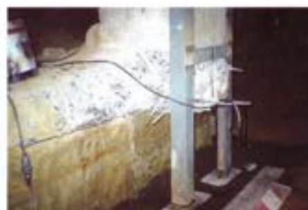
Teatros de S. Luiz e Mário Viegas. Recalçamento dos pilares que suportam a telha e a cobertura
