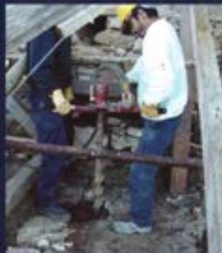
Execução de micro-estacas num local particularmente difícil
