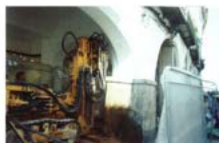
Execução da furação das microestacas
