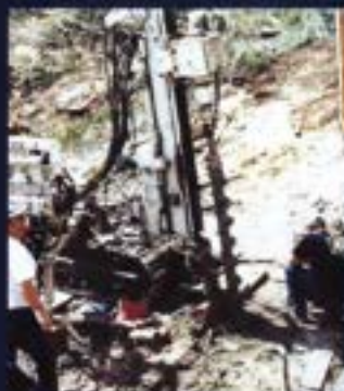
Execução de micro-estacas para estabilização de uma muralha
