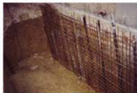
Teatros de S. Luiz e Mário Viegas. Recalçamento dos pilares que suportam a telha e a cobertura
