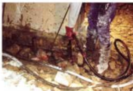
Teatros de S. Luiz e Mário Viegas. Recalçamento dos pilares que suportam a telha e a cobertura
