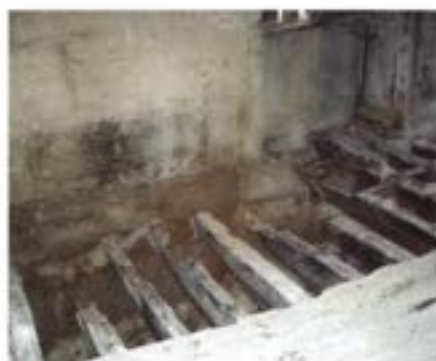
Detalhe de um pavimento do rés-do-chão, de madeira. Os estragos são sobretudo devidos à entrada da água da chuva
