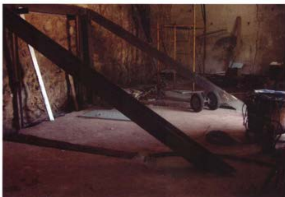
Fig. 3 - Palácio dos Condes da Leusã, Damalá. Escorrimento da parede de suporte de terras interior
