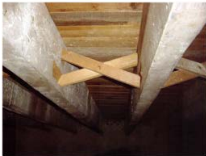
Fig. 2 - Tarçamento do pavimento de madeira através de duas diagonais
