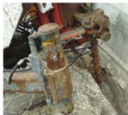
Palácio Pomal. Fase de execução do reforço de fundações da parede da fachada posterior do Palácio com microestacas
