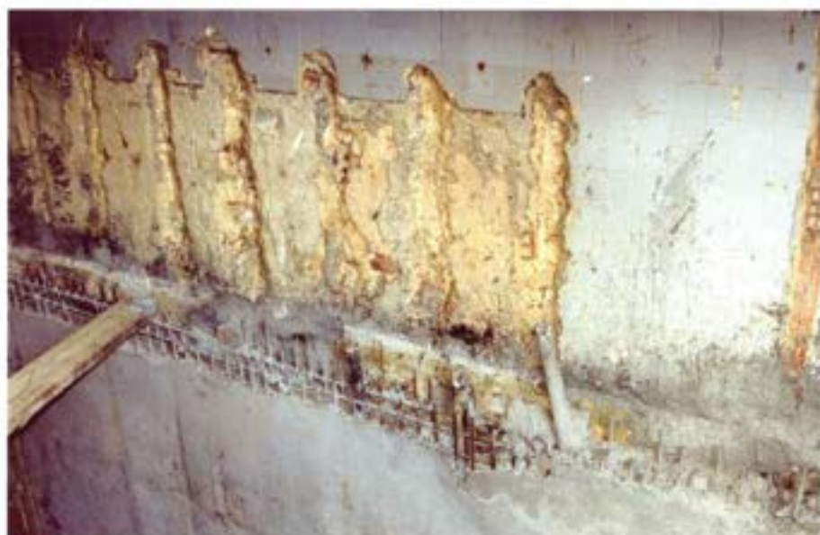
Teatros de S. Luiz e Mário Viegas. Fases do recalçamento de paredes com prévia execução de cortinas de microestacas
