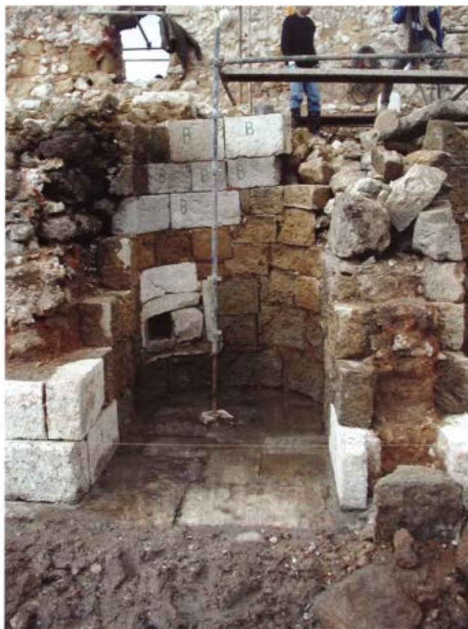
Moinho de Marés do Montijo. Fase de execução de fundações da fachada principal do moinho, com reconstrução do embasamento de pedra
