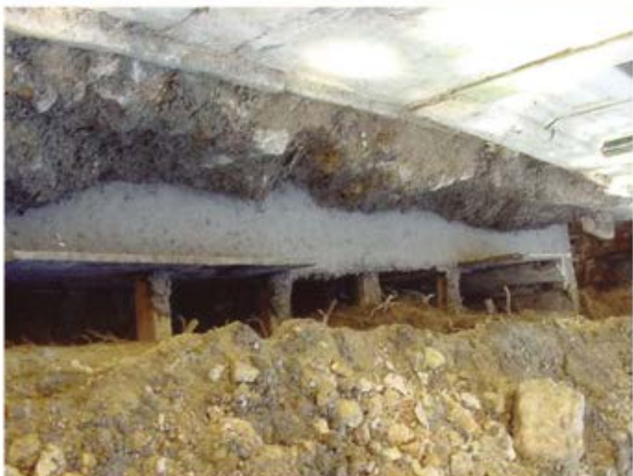
Palácio Pombal. Fases de execução do reforço de fundações da parede da fachada posterior do Palácio com microestacas
