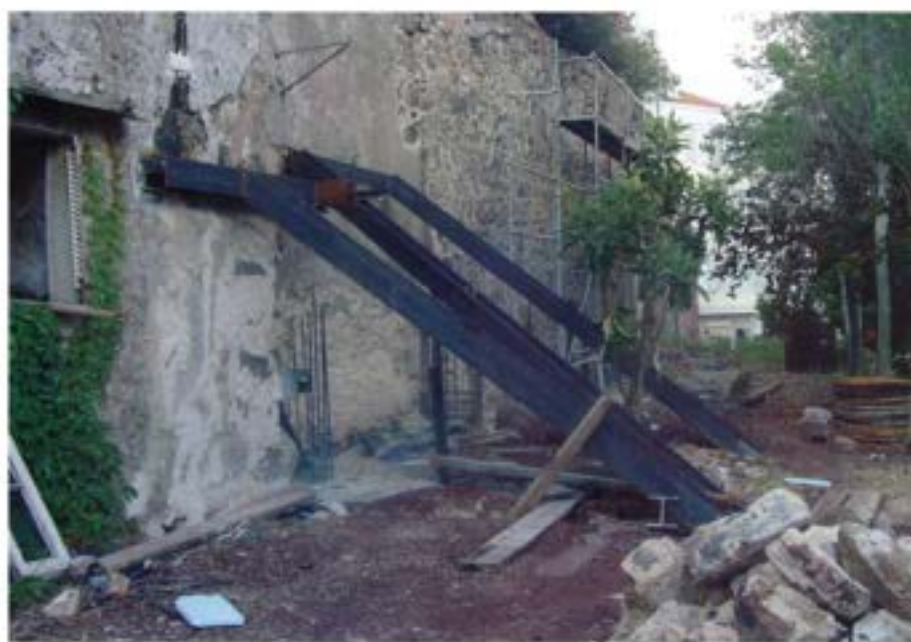
Fig. 4 - Palácio dos Condes da Lousã. Reforço do muro de suporte exterior. Escoramento provisório
