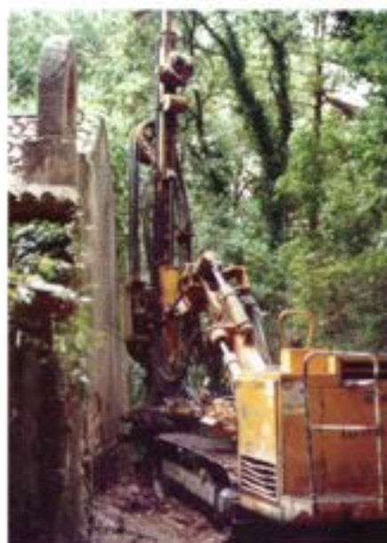
Fig. 6 - Ermida de S. Miguel, Buçaco. Reforço de fundações com microestacas e ancoragens. Furação para execução das microestacas
