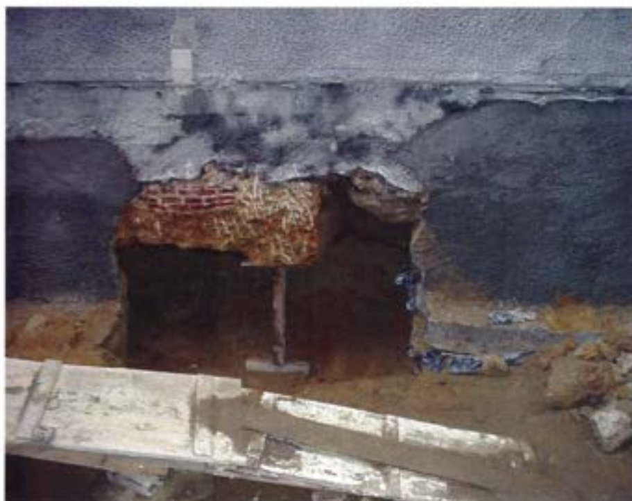
Fig. 1 - Troço de recalçamento da fundação
