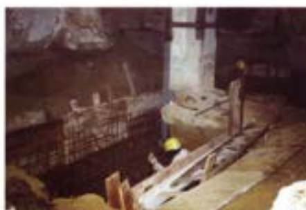
Teatros de S. Luiz e Mário Viegas. Recalçamento dos pilares que suportam a telha e a cobertura
