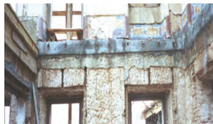
Fase de fixação das cintas por pregagem
