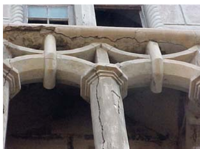
4 – Sintomas muito severos de corrosão das armaduras
