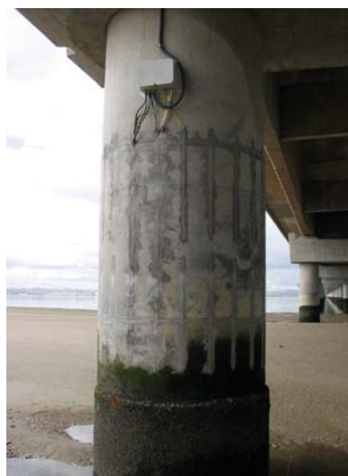
Figura 1 - Instalação dos ânodos
