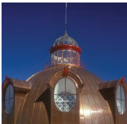
Zimbório: reconstrução em chapa de cobre
