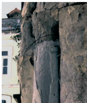
Sé Velha de Coimbra – desenvolvimento de colonização biológica por plantas superiores. As raízes destas plantas podem conduzir à fissuração ou mesmo à fracturação dos blocos pétreos
