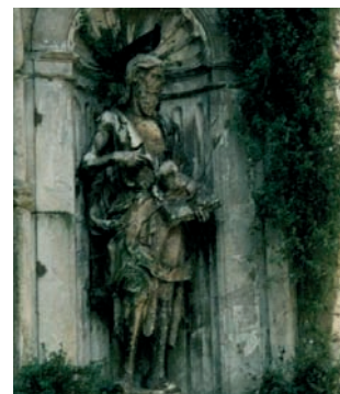
Sé Velha de Coimbra – fenómenos de esfoliação e lascagem, ou seja, destacamento de lâminas múltiplas de rocha, com espessura da ordem de um milímetro e de lascas com alguns centímetros de espessura, paralelas à superfície da pedra, respectivamente
