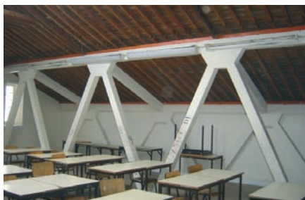
2 - Alterações estruturais, com elementos de betão armado
