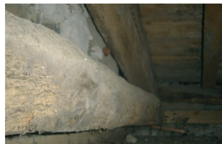
4 - Cobertura - ataque pontual e superficial de térmitas num barrote horizontal
