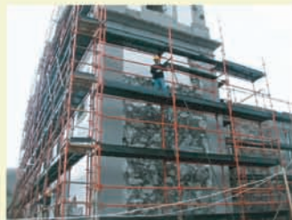
Picagem e remoção de argamassas desagregadas em rebocos e juntas.
