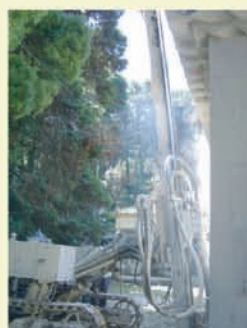
Execução de reforço e consolidação de fundações através de mini-estacas.
