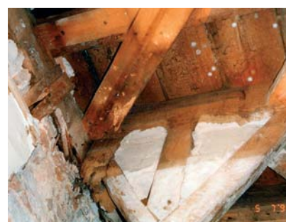
11 – Ferrolhos de ligação parede em frontal/parede principal
