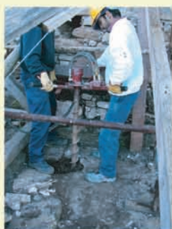
Execução de reforço e consolidação de fundações através de micro-estacas.
