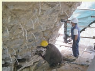
Consolidação de alvenarias antigas através da injeção de produtos inorgânicos.
