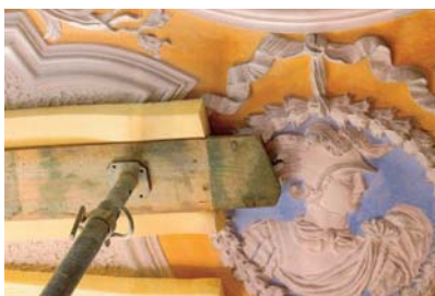
Tecto da escadaria - operações S.O. S. (protecções)
