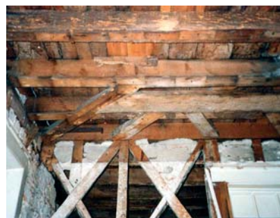
4 – Peças de ligação piso/frontal quando este é paralelo aos barrote do pavimento
