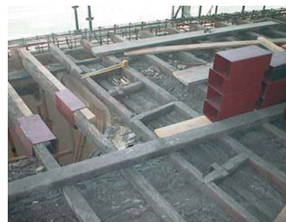
5 – Ferrolhos e tarugos de ligação parede interior/esteira
