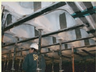
Aplicação de mantas e laminados de fibras de carbono para reforço de estruturas.
