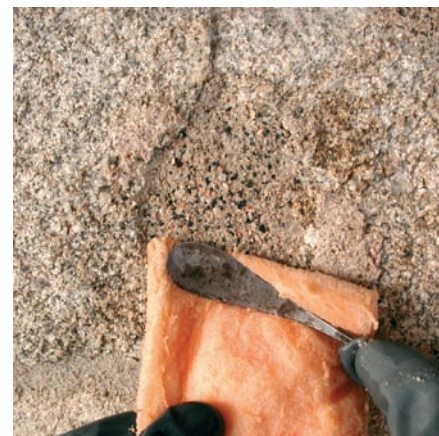
Fechamento de juntas – escolha da aparência exterior da junta
