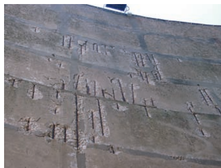
Corrosão de armaduras com delaminação de betão
