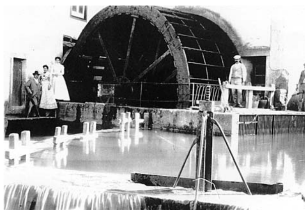
A roda hidráulica vertical da moagem A Nabantina, cerca de 1890. Foto de Silva Magalhães, Tomar
