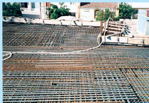
Foto 6: Mau dimensionamento. Excesso de armadura.
