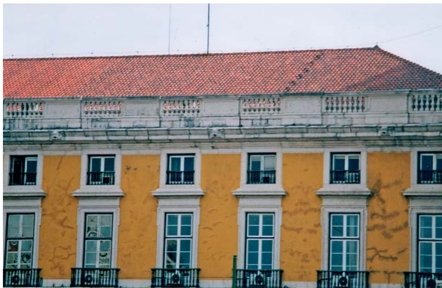
Manchas em paredes reparadas e pintadas por incompatibilidade dos materiais aplicados.
