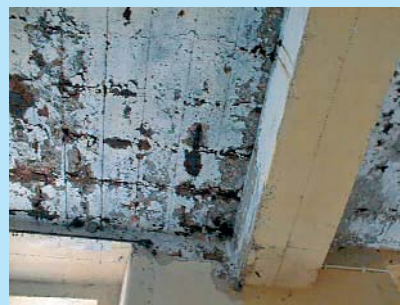
Foto 3: Corrosão das armaduras. Espessura de recobrimento insuficiente.
