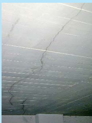
Foto 4: Fendilhação. Má concepção face às principais acções.
