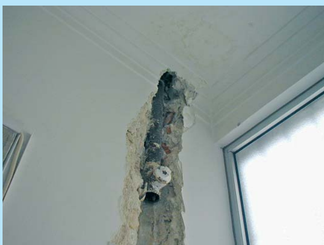
Foto 7: Infiltração de humidade. Dimensionamento inadequado das tubagens.
