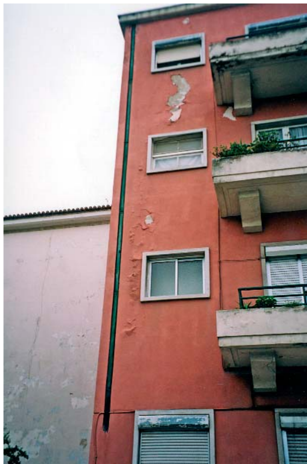
Formação de empolamentos e destruição de rebocos por aplicação do sistema de pintura impermeável ao vapor em obra de reabilitação.
