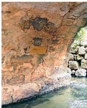
Aspecto do mau comportamento das argamassas à base de cimento Portland aplicadas no intradorso de um dos arcos
