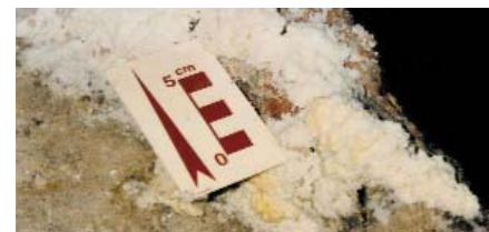
Foto 2: Desenvolvimento de eflorescências salinas na borda NW da piscina do Banho da Rainha.
