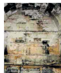
Foto 1: Banho da Rainha (parede W). São visíveis os intensos fenómenos de degradação ao nível dos materiais pétreos.
