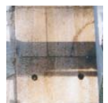
Figura 6: Furos para a execução de pregagens de ligação na intersecção de paredes ortogonais.
