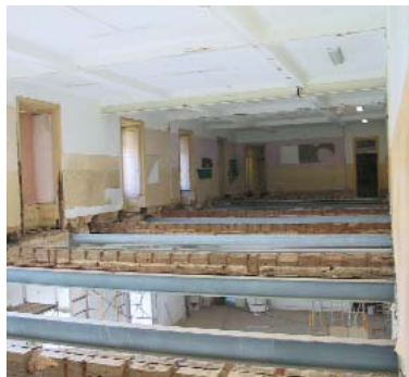
Vista geral da estrutura existente em madeira e nova metálica.
