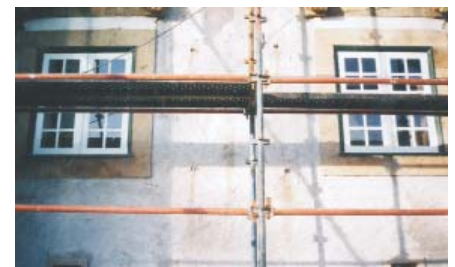
Figura 5: Furação nos nembo para colocação de conectores de solidarização dos dois panos das paredes.
