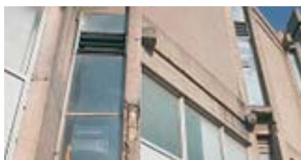
Fig. 5 - Degradação avançada da fachada de um edifício em betão à vista, em resultado da corrosão das armaduras. Note-se a grande extensão da superfície de betão exposta, a pequena espessura dos elementos e a profusão de arestas, facilitando o avanço da carbonatação do betão.
