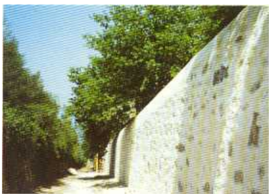
Mosteiro de S. Martinho de Tibães — Muro da cerca, após aplicação de argamassas de suporte, consolidação e revestimento.
