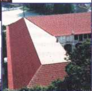
Convento de S. Francisco Coimbra Reabilitação e beneficiação das coberturas Execução de cobertura dupla com isolamento
