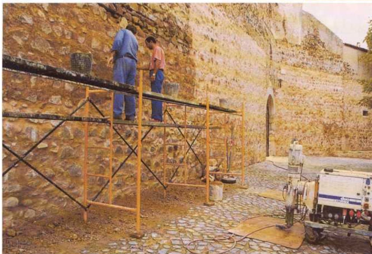
Vista da aplicação de reboco de consolidação nas muralhas do castelo de Sines
