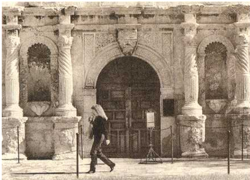
Entrada principal do Forte Álamo, exibindo sinais evidentes de erosão da pedra, devido a humidade ascendente
