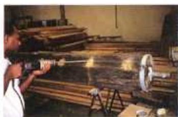
Construção e reforço de um antigo mastro de um moinho de vento tradicional
