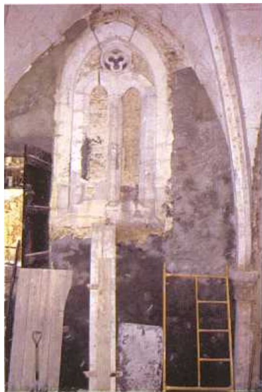
Fig. 3 - Desentulhamento e consolidação da capela gótica principal
