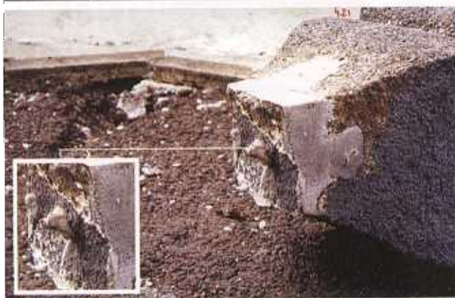
Igreja de Castelo Branco (Faial) - Elemento de atiramento aplicado após o sismo da década de 20
