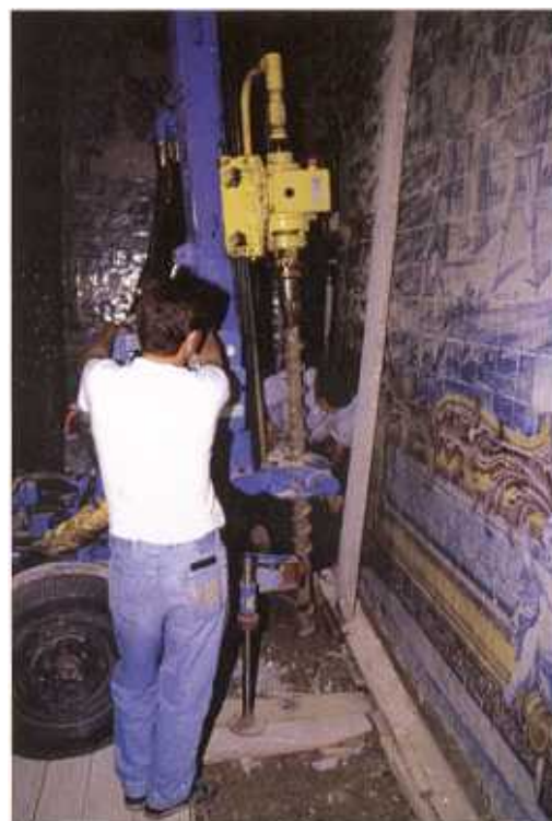
Fig. 1 - Perfuração para micro-estacas
