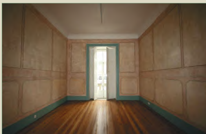
Tratamento de pintura mural decorativa, no Liceu Sá de Miranda, em Braga. A intervenção, para além dos normais procedimentos de conservação e restauro, implicou o levantamento de inúmeras camadas de pinturas existentes (Atelier Samthiago, Ld. a ).
