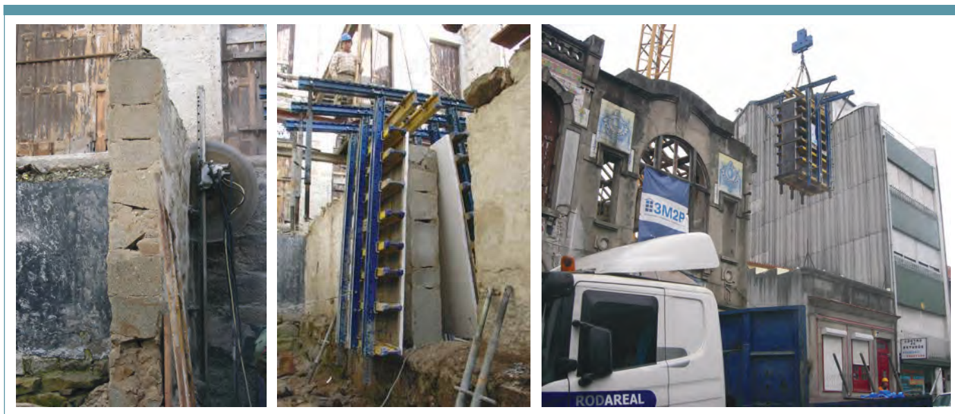
2 - Painéis de parede: corte, extracção e transporte para o laboratório.
