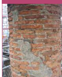
4 – Vestígios de argamassa de recobrimento.
