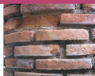
6 – Perda volumétrica em elemento cerâmico.
