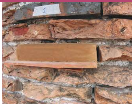
11 – Reconstrução volumétrica de elemento cerâmico.
