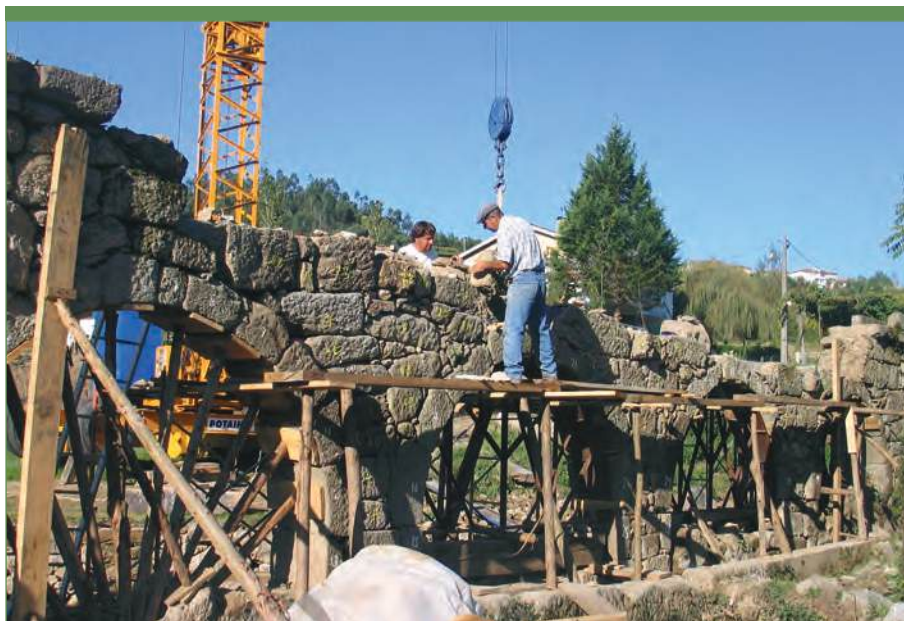
3 – Remonte na zona central com reposição da verticalidade.
