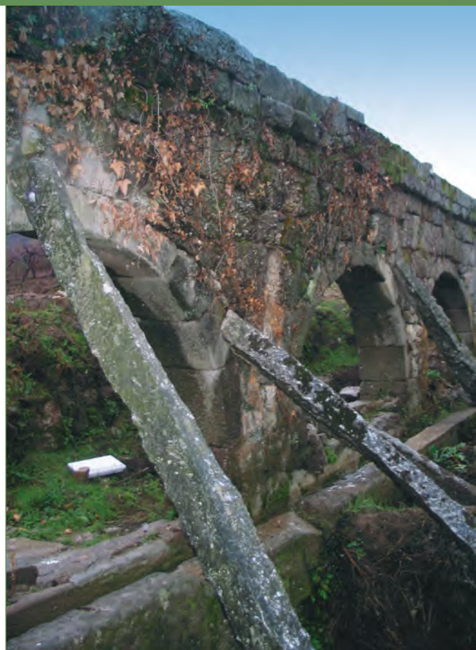
2 – Escoramento com esteios de granito nos arcos da zona central.
