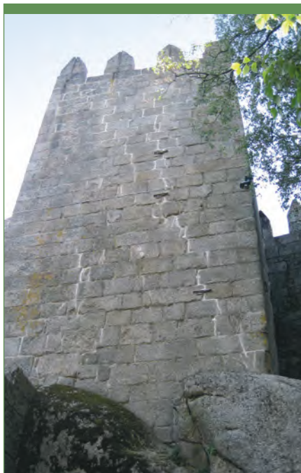
7 – Monitorização do cunhal após consolidação de maciços e refechamento de juntas.
