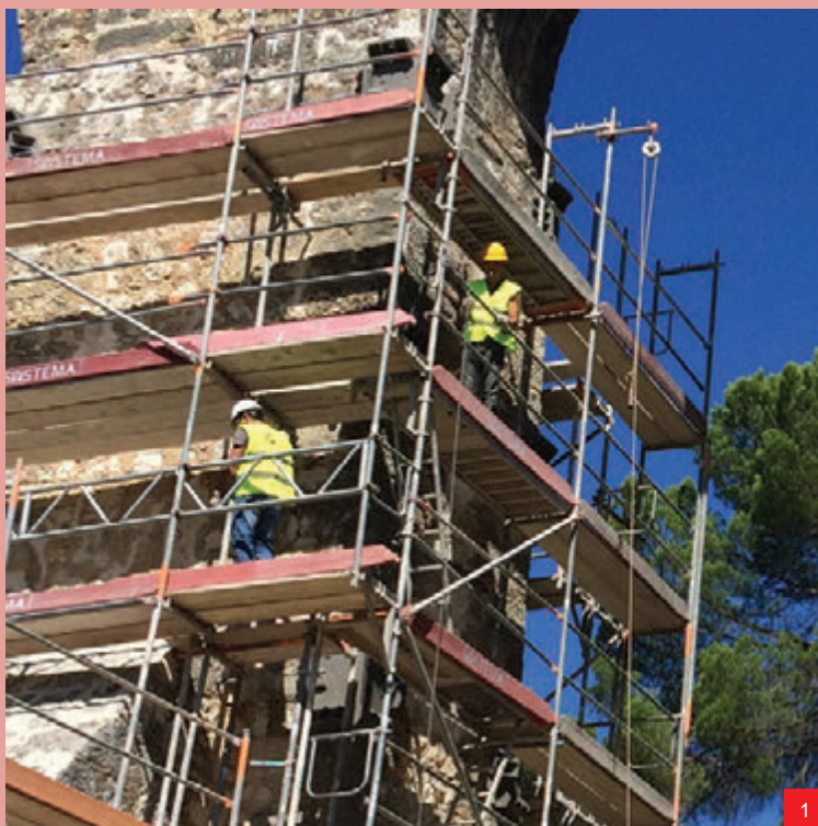
1 | Reforço de um pilar de alvenaria de pedra.
