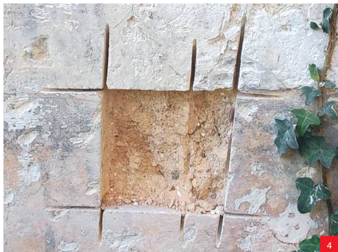
4 | Nódulos de cal viva visíveis nas camadas internas do revestimento.
