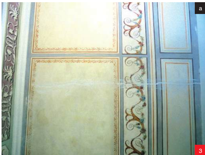
3 | Revestimentos decorativos restaurados em a) parede (com fissura visível) e b) teto
