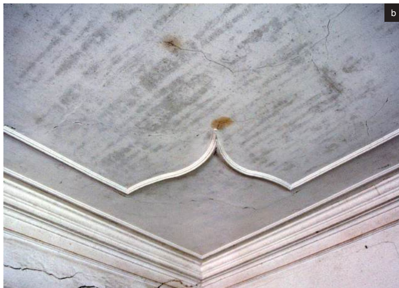
4 | Molduras e frisos moldados “in situ”, enquadrando elementos decorativos pré-moldados (século XIX): a) Palácio de Barahona, Évora; b) Palácio da Anunciada, Lisboa.
