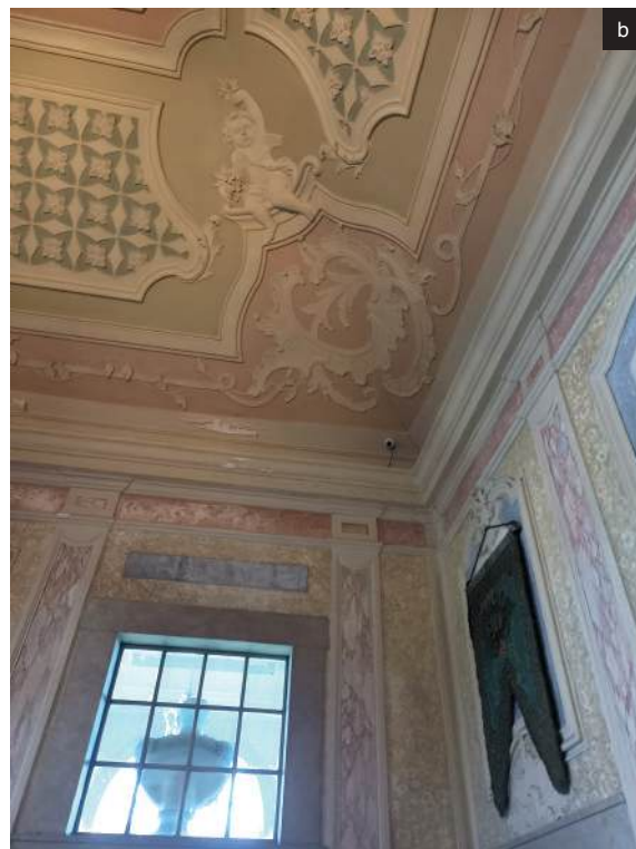
3 | Revestimentos decorativos restaurados em a) parede (com fissura visível) e b) teto
