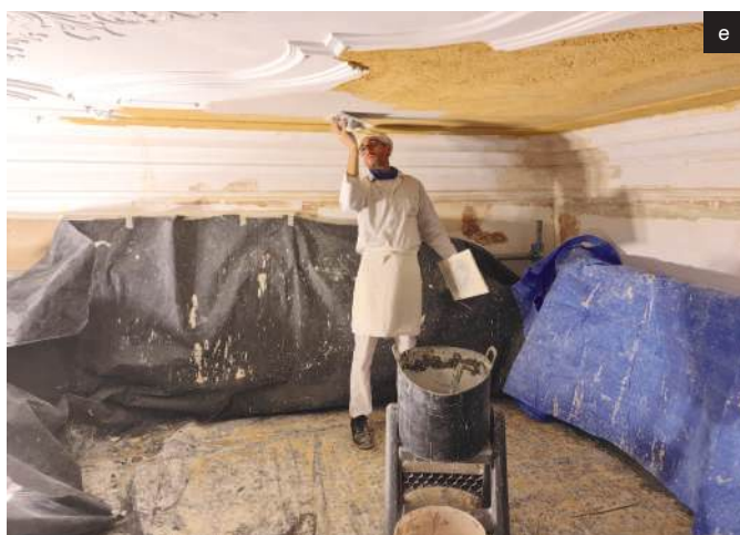
4 | a) Sequência de ações de restauro de um teto muito danificado. b) Teto destruído por infiltração de água a partir de um nível superior. c) Colocação de vigamentos e de fasquias novas. d) Execução da camada de emboço, com muito bom aperto entre as fasquias. e) Preparação e colocação da camada de estuque liso.
