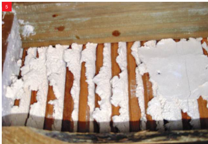
5 | Exemplo das “chaves” formadas pela argamassa ao aderir ao fasquiado.
