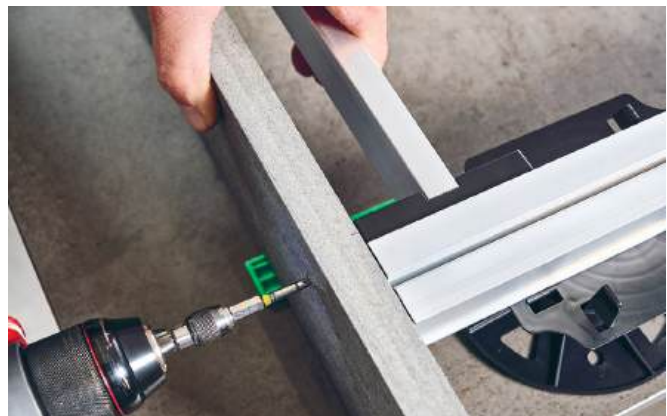
Blendenbefestigung mit Adapter für Queraussteifung
