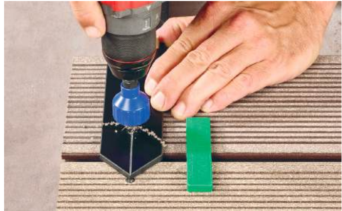
1. Schablone mittig zur UK anlegen und Löcher markieren
