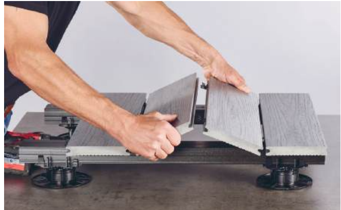
1. Montageklammern seitlich aufstecken
