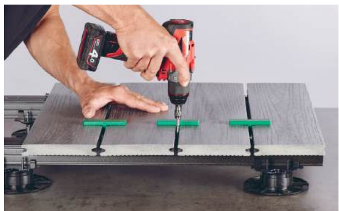
3. Montageklammern wieder festverschrauben
