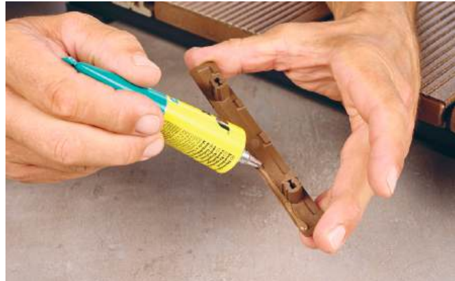
1. Kleber auf obere Kantenseite anbringen
