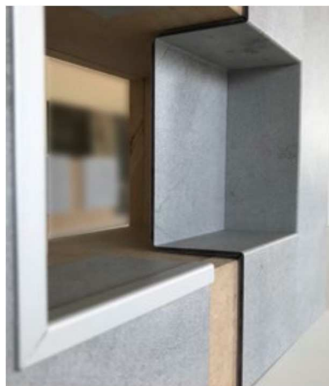
Nischenverkleidung 1 Platte seitlich gekantet, 1 Platte 4-fach gekantet
