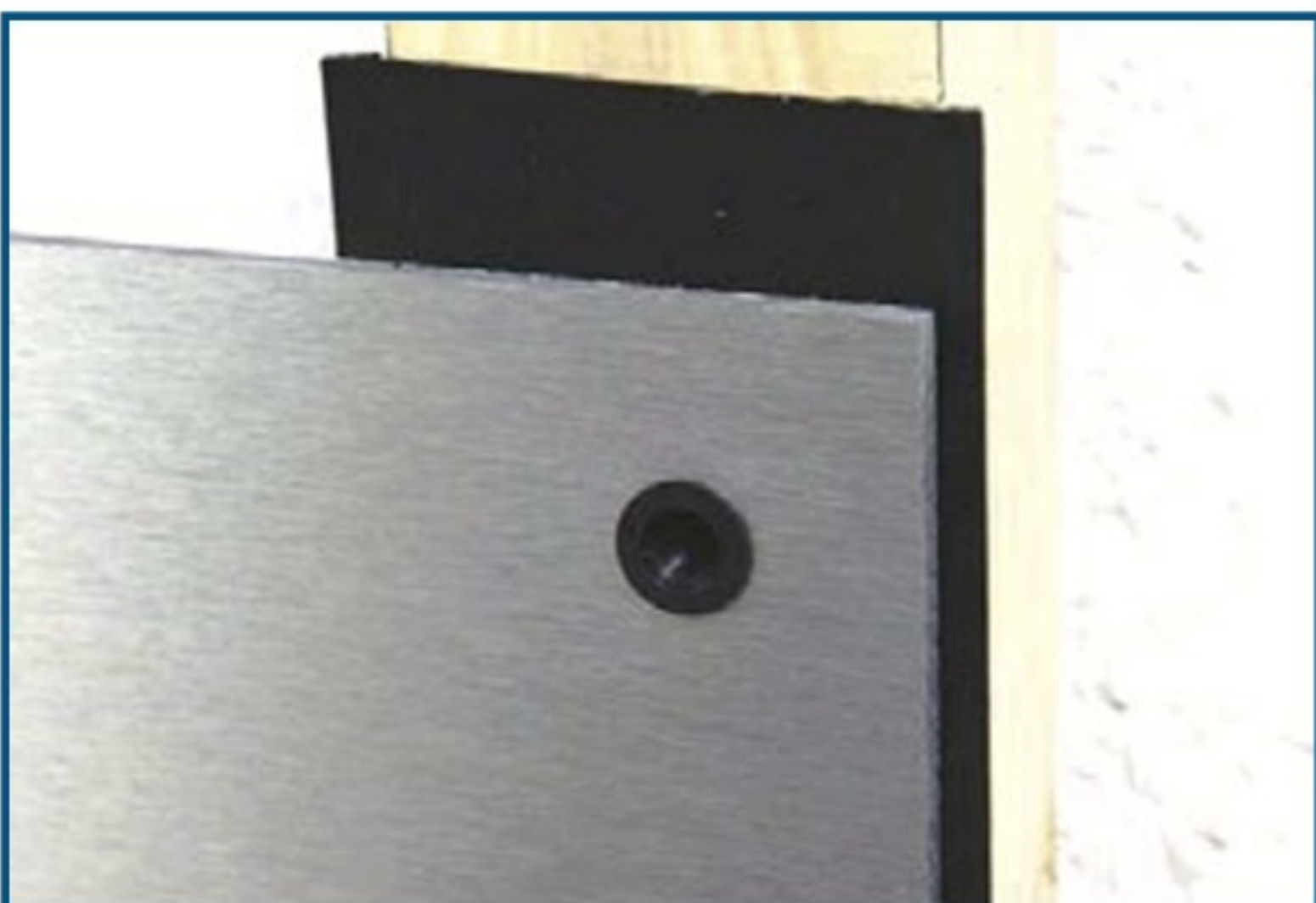
Abb. 11 - Gleitpunkt: Fa-Ze-Di-Ring in Plattenbohrung
