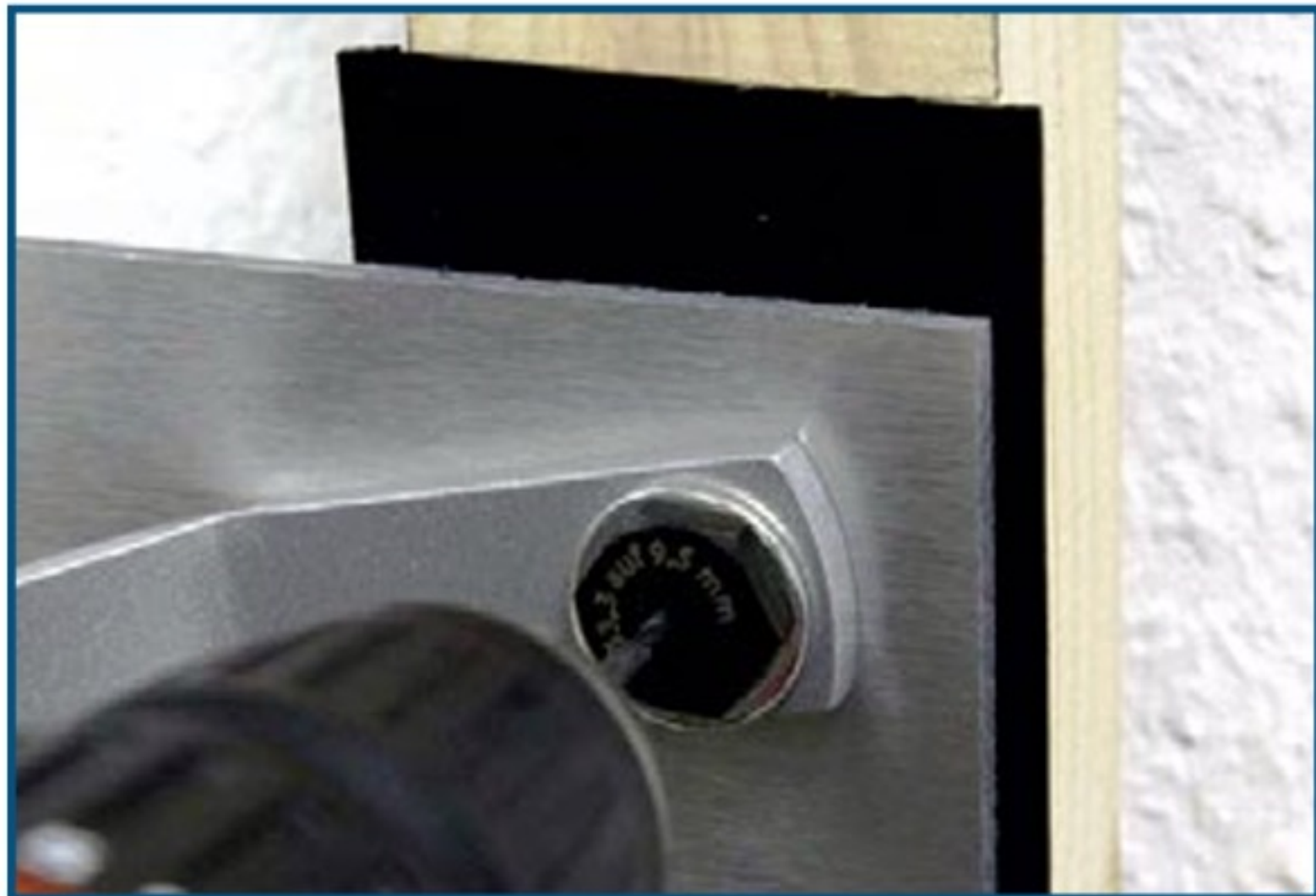
Abb. 9 - Einsatz Bügelbohrvorrichtung, Vorbohren der Holz-UK
