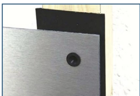
Abb. 11 - Gleitpunkt: Fa-Ze-Di-Ring in Plattenbohrung
