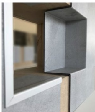
Nischenverkleidung 1 Platte seitlich gekantet, 1 Platte 4-fach gekantet
