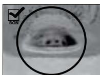
TIGE OVALE DU BOULON ASSISE ADÉQUATEMENT
