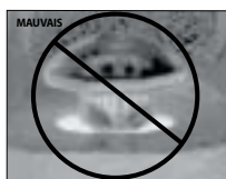
TIGE OVALE DU BOULON PAS ASSISE ADÉQUATEMENT
