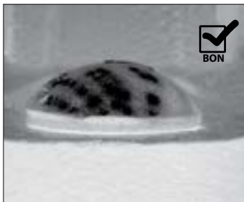
ENGAGEMENT ADÉQUAT DU BOULON (LE COU OVALE DE CHAQUE BOULON EST BIEN INSÉRÉ DANS SON TROU)
