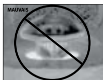
TIGE OVALE DU BOULON PAS ASSISE ADÉQUATEMENT
