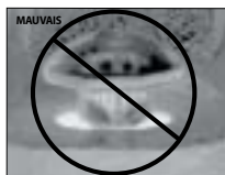
TIGE OVALE DU BOULON PAS ASSISE ADÉQUATEMENT
