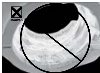
Joint d'étanchéité Installation-Ready incorrectement lubrifié avec trop de lubrifiant
