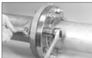
Séquence de serrage pour 4 boulons
