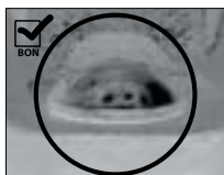
TIGE OVALE DU BOULON ASSISE ADÉQUATEMENT
