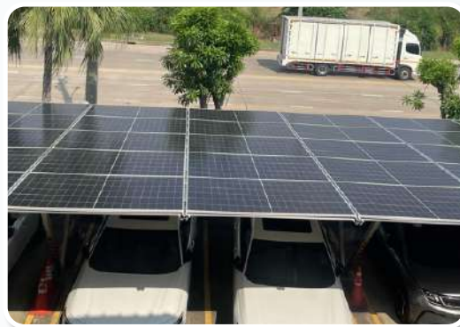
หลังคาโรงรถ
