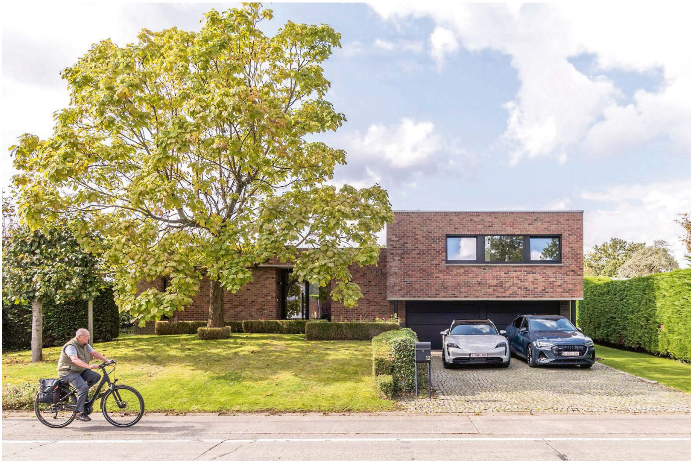
De geometrische volumes en de bakstenen gevel illustreren de typische stijl van de jaren zestig.
