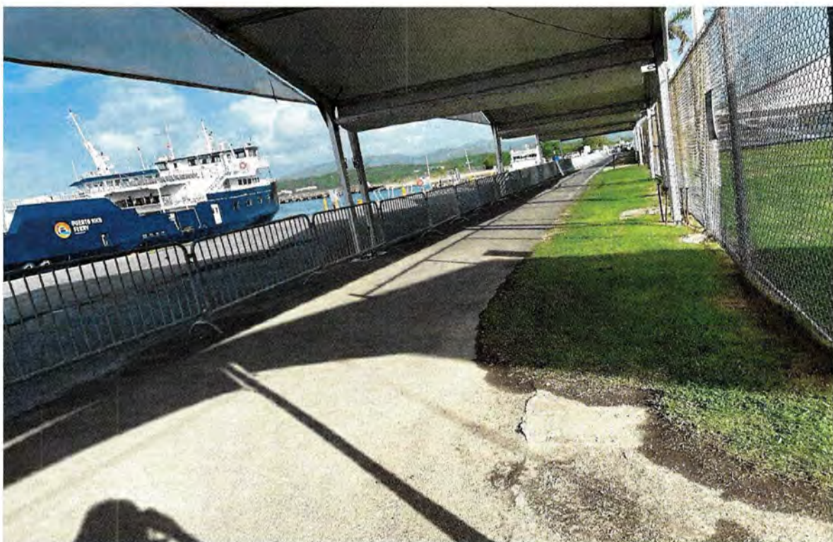
Pasillo cubierto de carpas que lleva desde la boletería hacia el área de abordar el Ferry. Protegiendo a los ciudadanos de las inclemencias del tiempo.
