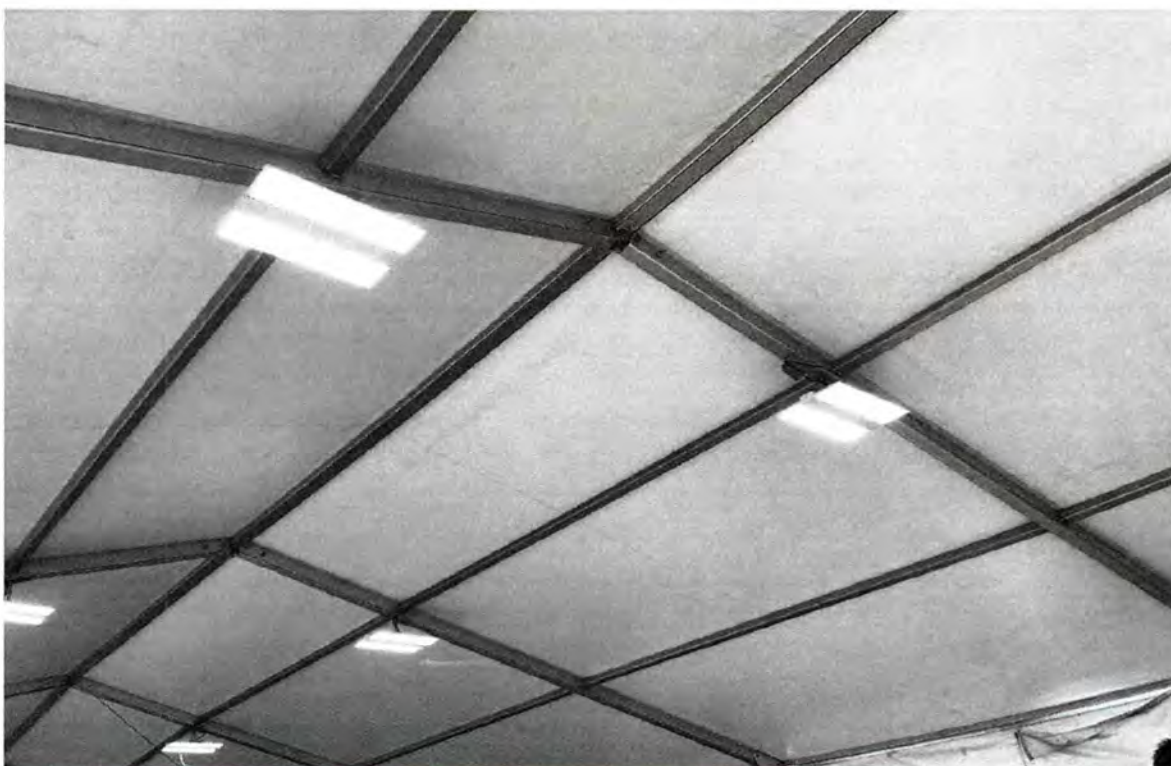
Carpas nuevas instaladas.
