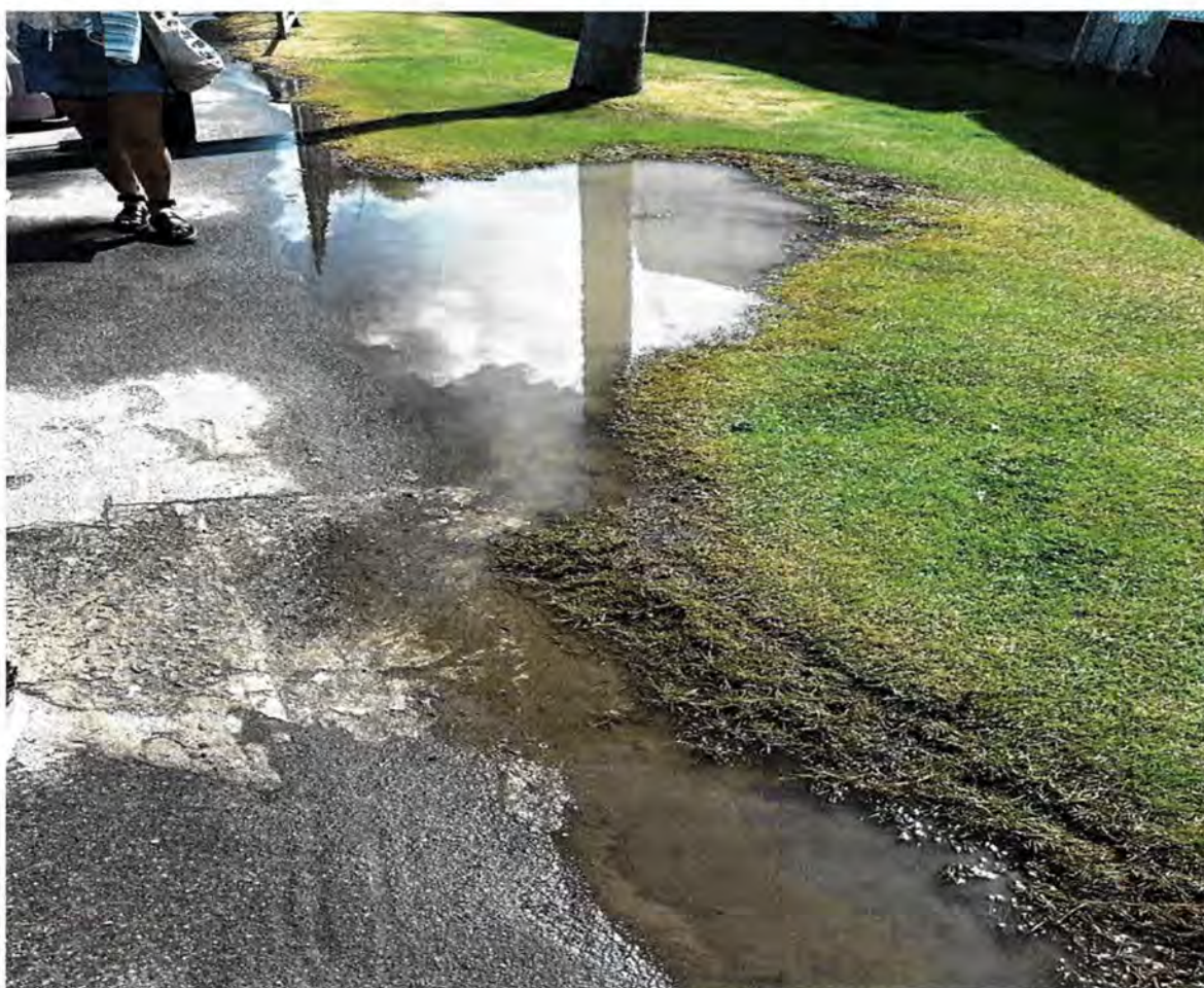
Area de la rotonda y alrededores del Terminal.
