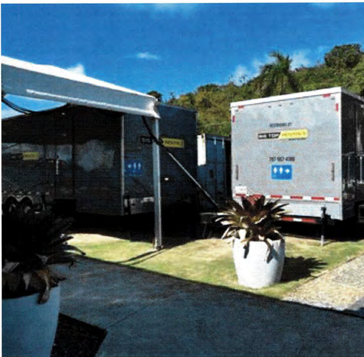
Baños vagones- sustituyen a los portátiles.
