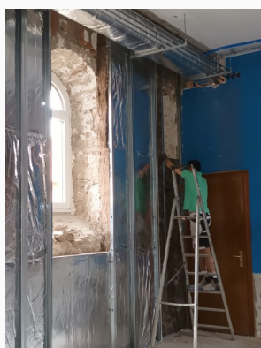
Isolation intérieure des murs
