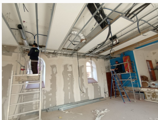
Pose des panneaux rayonnants dans la salle du rez de chaussée
