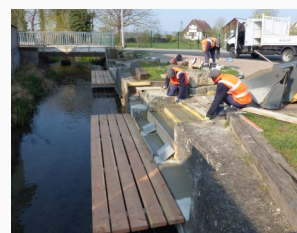
Avril 2019 : installation des bancs au droit des anciens lavoirs
