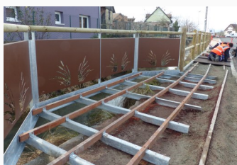
Février 2019 : installation du ponton
