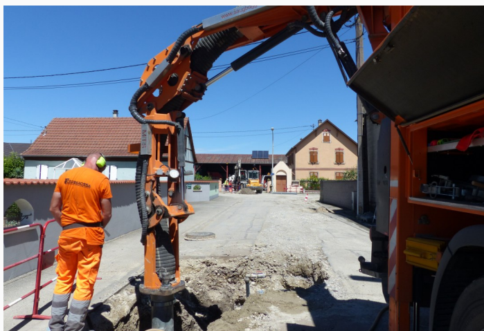
Utilisation d'un camion aspiratrice-excavatrice. Rapide et fiable, cette technique permet de limiter les risque d'endommagement de réseaux enterrés .
