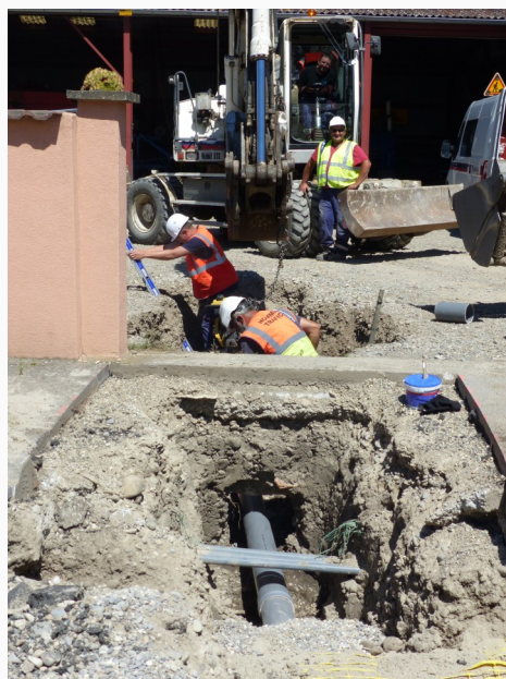
Raccordement des eaux usées au droit d'un particulier.
