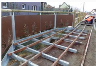
Février 2019 : installation du ponton
