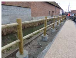
Janvier 2019 : mise en place du garde-corps
