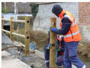
Janvier 2019 : mise en place du garde-corps
