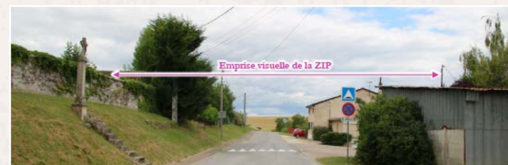
Photo 15 : Vue en direction de la ZIP, située dans l'axe de la rue Basse à Laneuville-au-Rupt (Source : BEJC)
