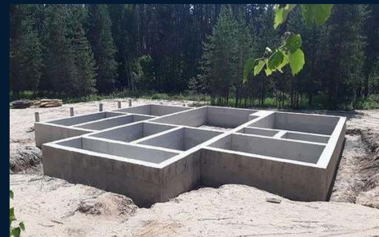
Обвязка свай ростверк/брус
