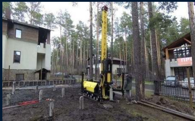
Pemasangan tiang pancang
