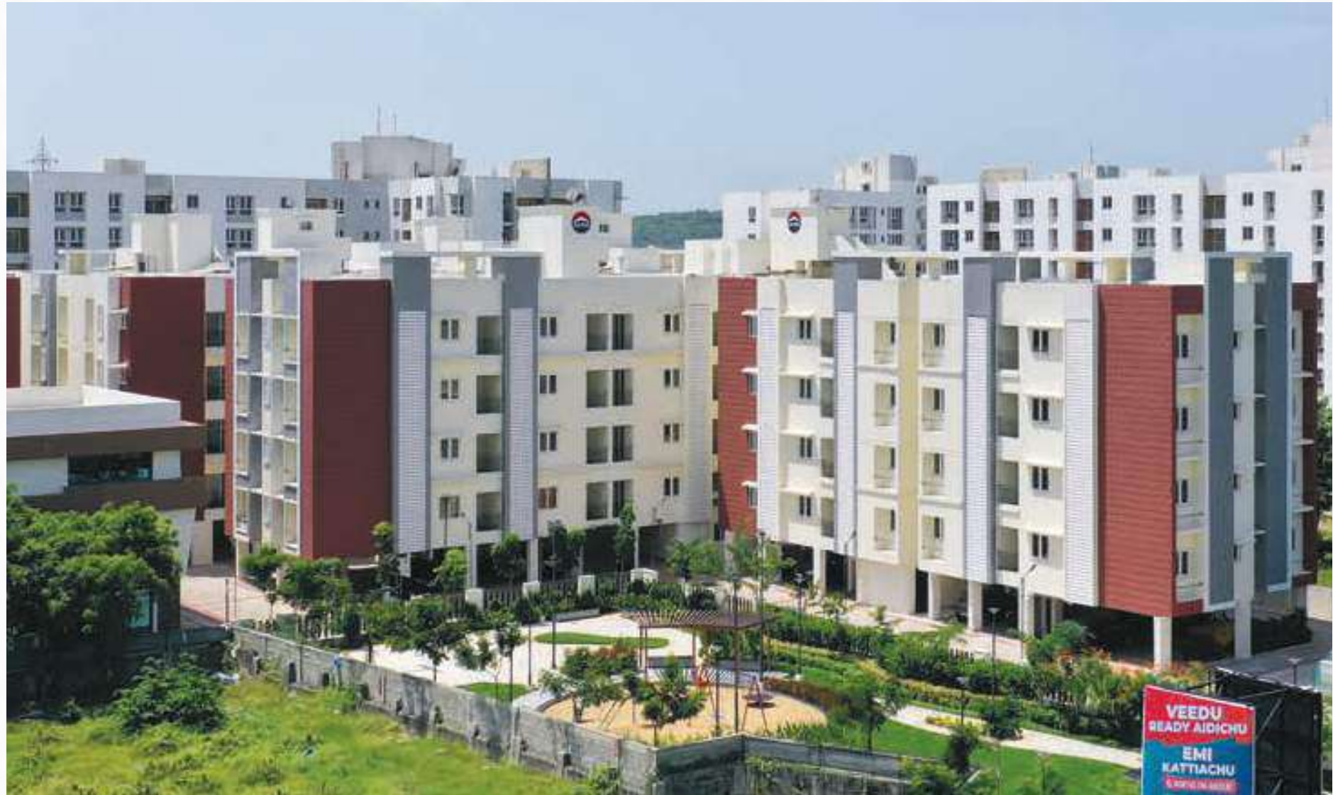
ACTUAL SITE PHOTO
