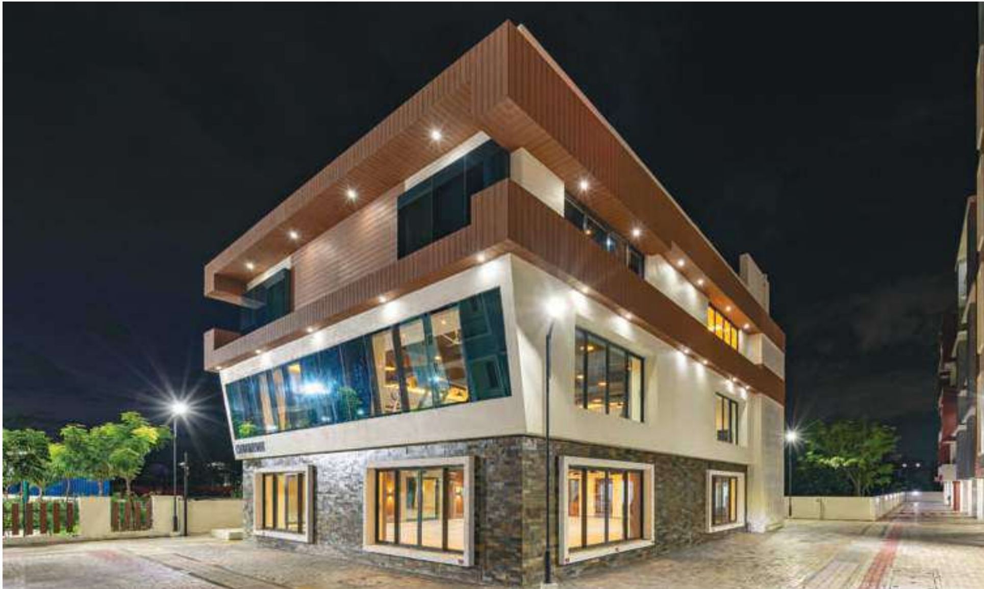
ACTUAL SITE PHOTO
