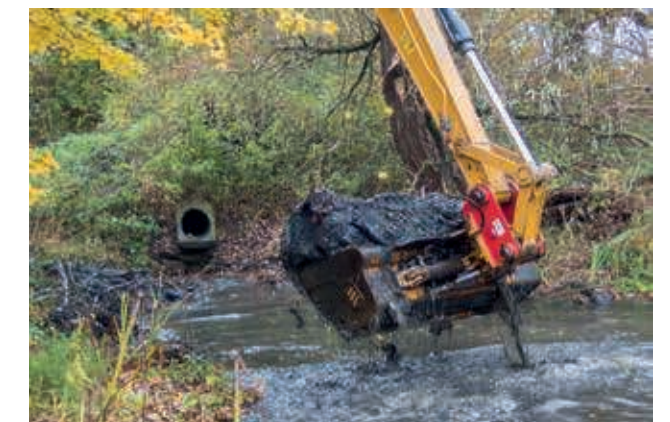
ENTSCHLÄMMUNG MIT BAGGER ///
