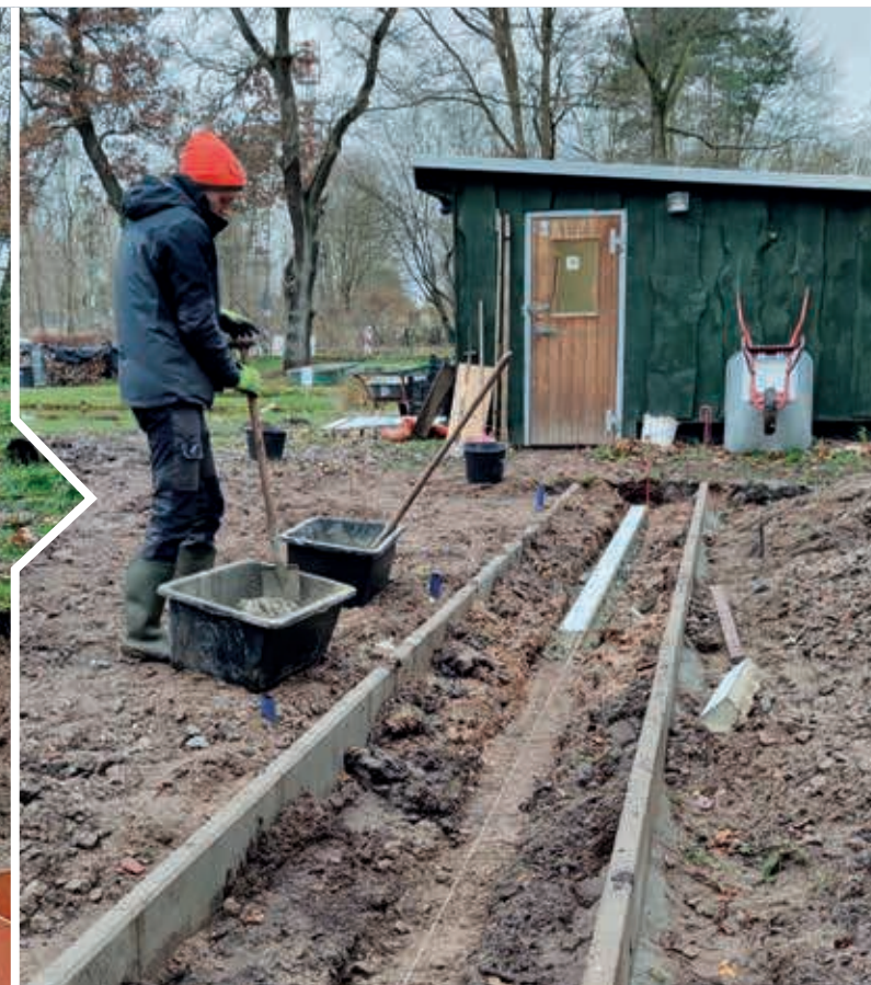
BAU DER RINNE ///
