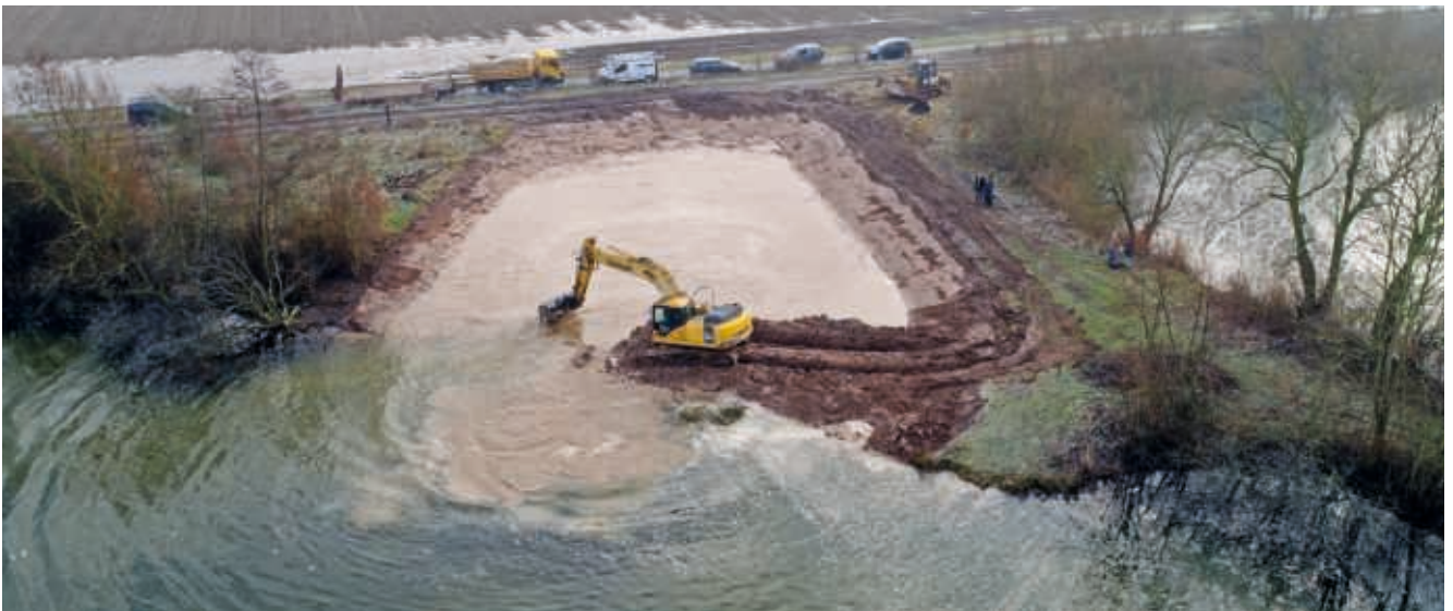
Ein Bagger gräbt eine Flachwasserzone am Versuchssee Donner Kiesgrube 3 bei Nienburg. Der abgetragene Boden musste abtransportiert werden und fand bei einem lokalen Landwirt einen Abnehmer. © Thomas Klefoth
