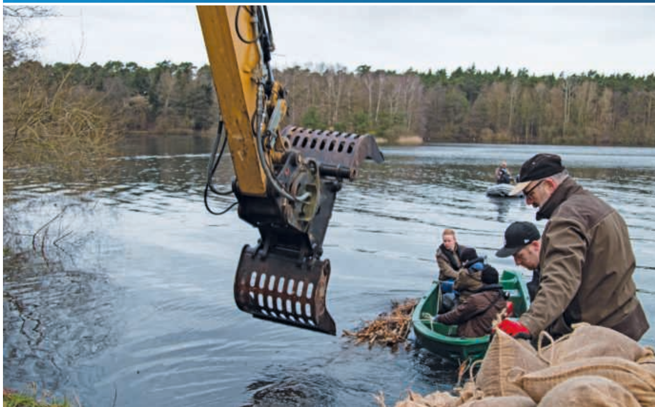
Die Bündel werden mithilfe eines Baggers und mit Motorbooten in ufernahe Bereiche des Sees transportiert. © BAGGERSEE
