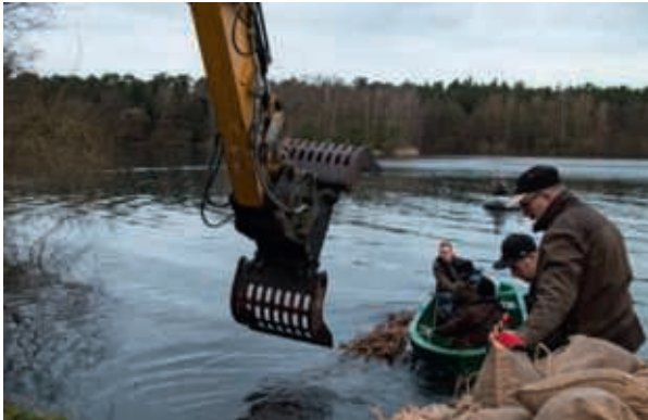
Abbildung 113: Die Totholz-bündel werden zum Ausbringen seitlich an einem Motorboot befestigt. Auf einen Bagger kann bei handlichen Bündeln verzichtet werden.
