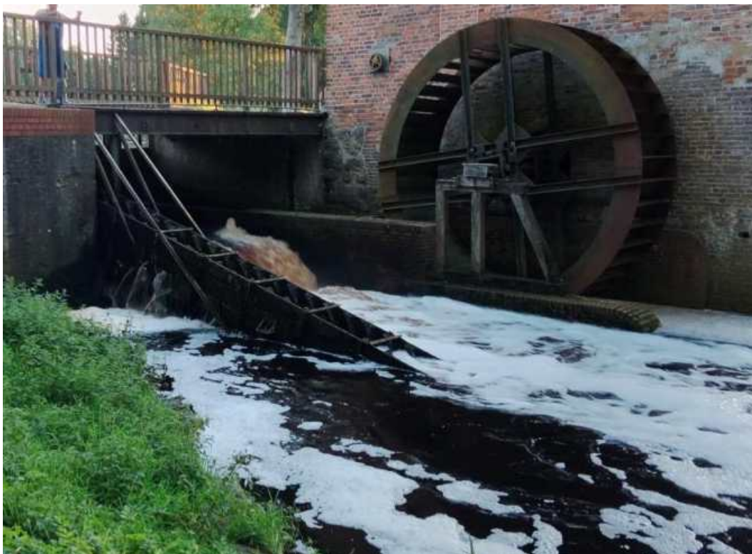
Abb. 8-9: Durch den Wehrüberfall in Bademühlen (unteres Bild) wurde nach 10 km Lauflänge wieder viel Sauerstoff in die Bade eingetragen und der Unterlauf der Bade auf einer Länge von ca. 3,2 km wahrscheinlich von größeren Fischsterben bewahrt. Der Stauteich (oberes Bild) wurde auf Anregung der Wasserbehörde am 15.8.2023 abgelassen, um die Belastung aus der oberen Bade schneller abzuführen (Fotos: Ralf Gerken / AVN).
