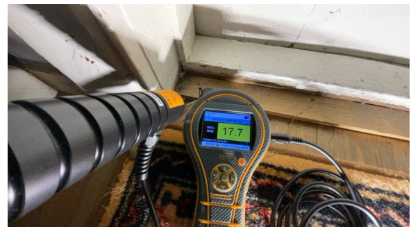
Fuktmåling i gulv i gang over lukket gulvkonstruksjon.
