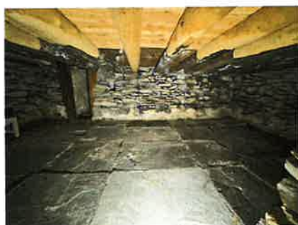
Dette rmontert nye takåser i delar av etasjeskille.
