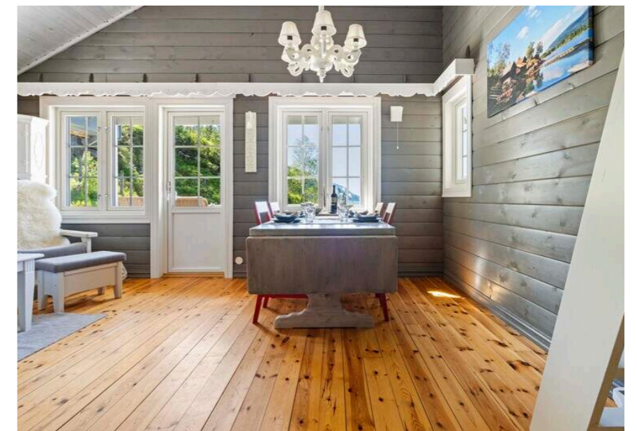
- Innvendige vegg- og himlingsflater er malt og beiset -
