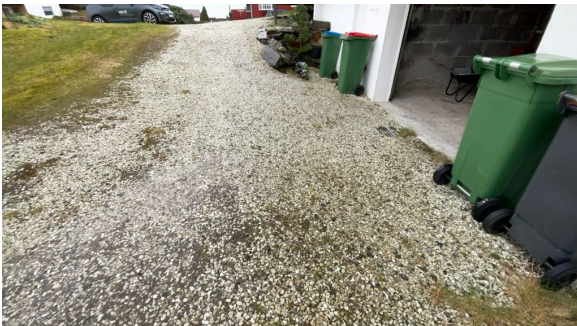
Terrang ved innkjørsel til garasje.
