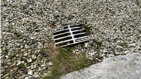
Kum/rist ved innkjørsel til garasjen.
